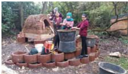
2016 wurde der Lehmofen gebaut.
